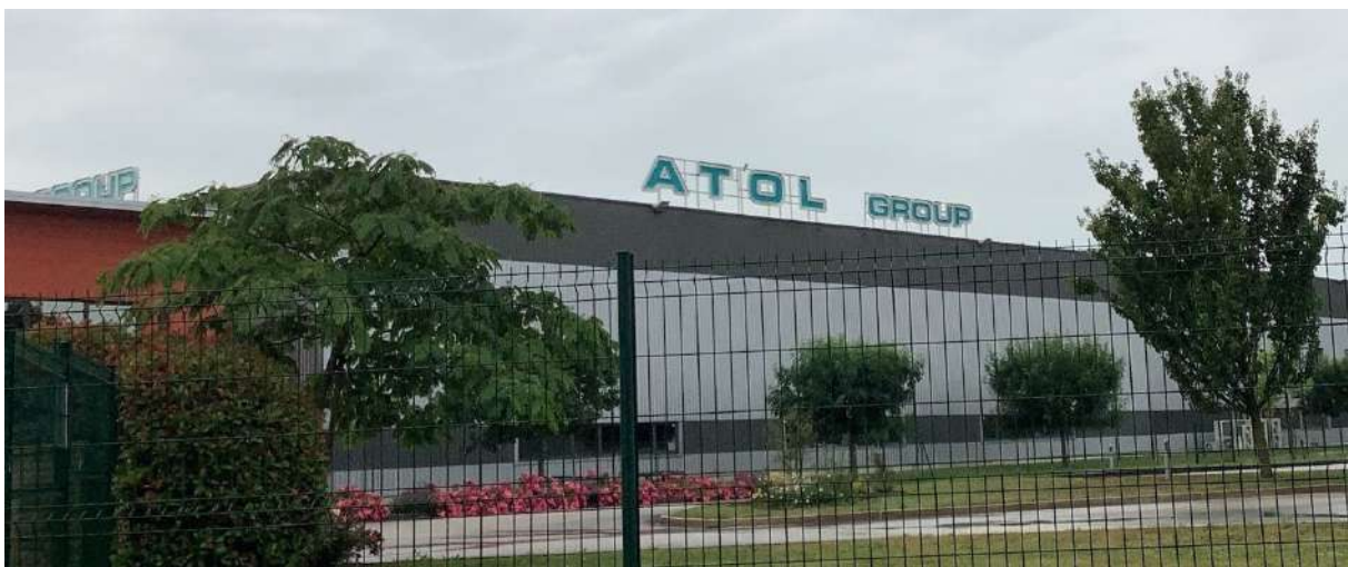
Enseignes sur toiture excédant les limites surfaciques règlementaires
