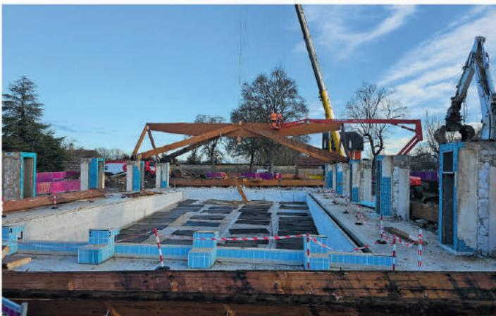
Au stade nautique, la première phase des travaux a marqué la fin d'une époque avec la démolition du plongeoir et la dépose intégrale de la charpente. Les travaux ont tenu les délais avec la fin de la déconstruction qui voit également la séparation du stade nautique du pavillon anglais. Le mois de mars a laissé place aux opérations de terrassement et aux travaux préparatoires avant le début du gros œuvre dès le mois d'avril.
