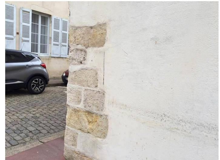
Pierres de chaînage étant destinées à être recouvertes
