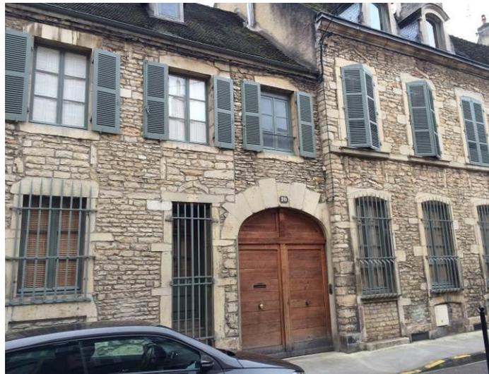
Mur devant être enduit pour retrouver les qualités thermiques initiales et mettre en valeur les pierres
