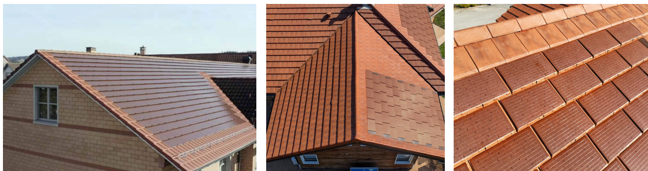
Figure 26 : Modèles de tuiles solaires à base de terre cuite sur couvertures de tuiles plates « grand moule ».
